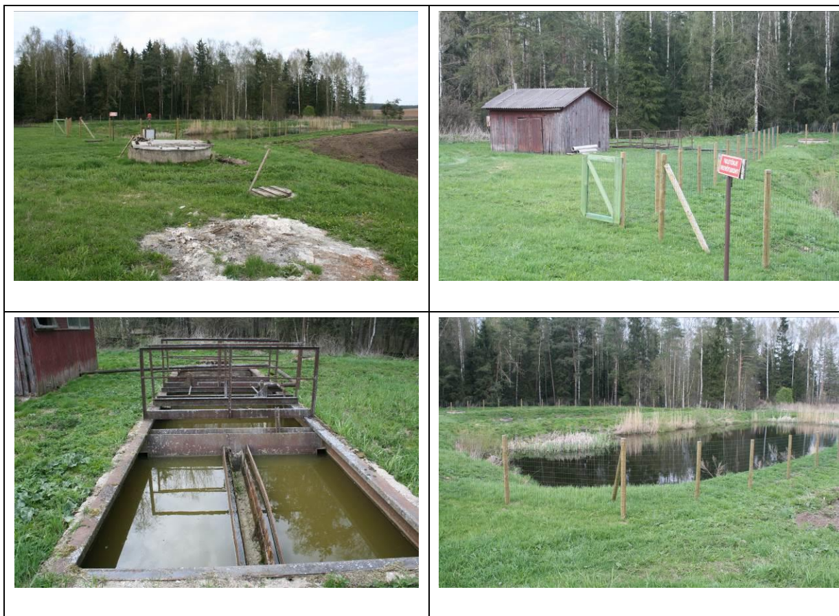
Joonis 7. Aarna küla reoveepuhasti. Fotod: OÜ Alkranel 6.05.2015.
