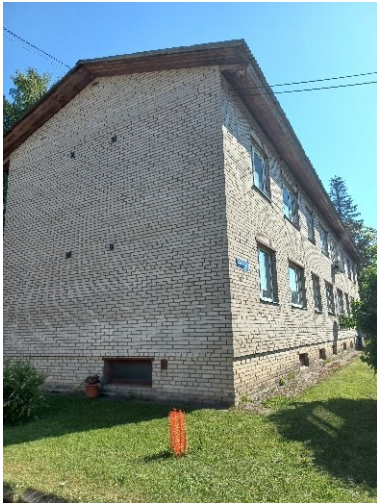
Vabriku 39- katuse ehitus- või ümberehitustööd (ehitust ei ole alustatud)
