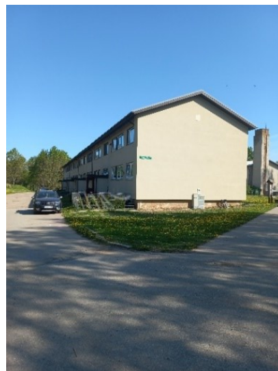
Lasteaia tee 5- otsaseinte soojustus (tööd teostatud)
