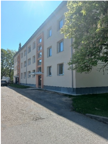
Jaama 22 – Välisfassaadi ehitus- või ümberehitustööd (tööd teostatud)
