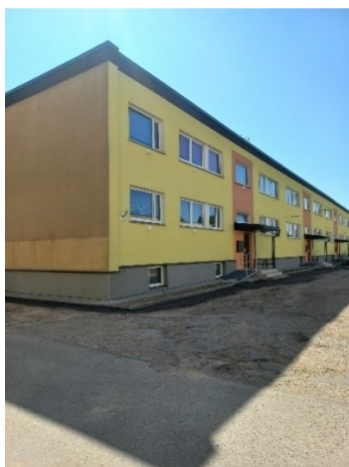
Sireli 5 – Sisepääsu varikatused, sokli soojustamine, katuse vahetus (tööd teostatud)
