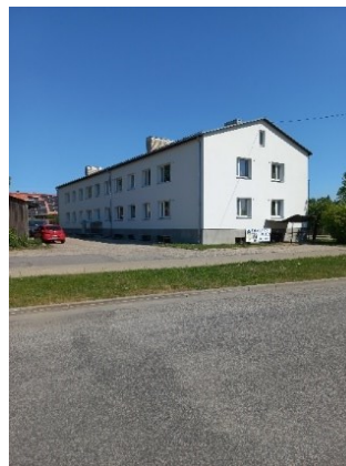
Käisi 3 - Välisfassaadi ehitus- või ümberehitustööd (tööd teostatud)
