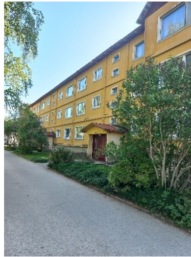
Lasteaia tee 4 - katuse ehitus- või ümberehitustööd (alustatud lammutustöödega)
