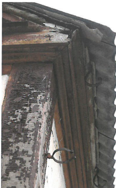
Foto 4: Vaade hoone nurga- ja räästalahendusele ning vihmaveetoru sepiskonsoolile
