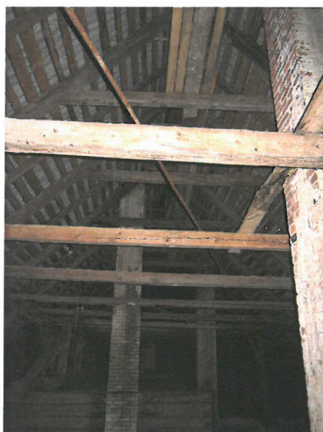
Foto 9: Vaade hoone keskosa katuse kandekonstruktsioonidele
