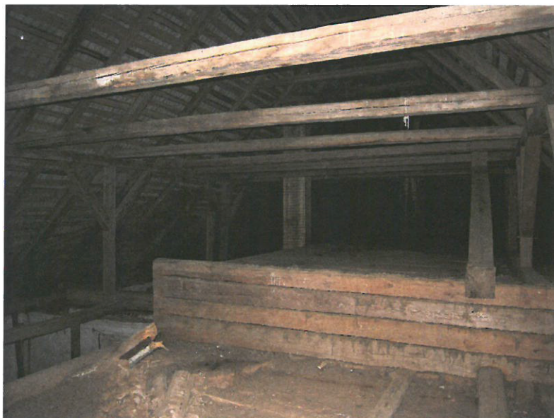
Foto 8: Vaade hoone keskosa pööningule
