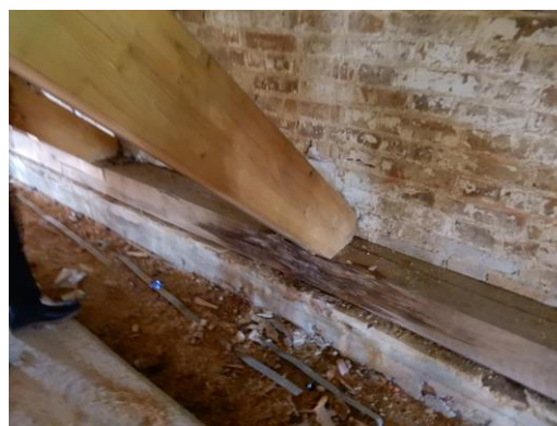
Sarika otsa toetumine niiskuskahjustusega müürilatile
