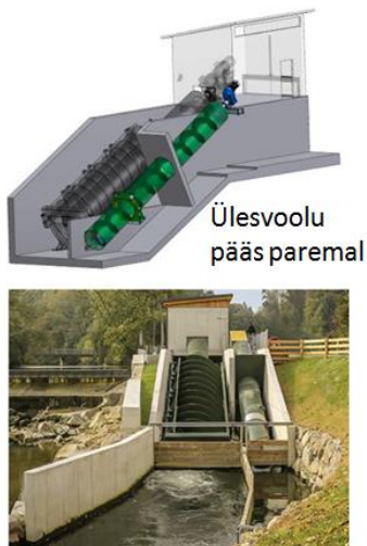
Joonis 1.5. Näidis kruvikalapääsust. Allikas: REHART/Strasser, 2016.
