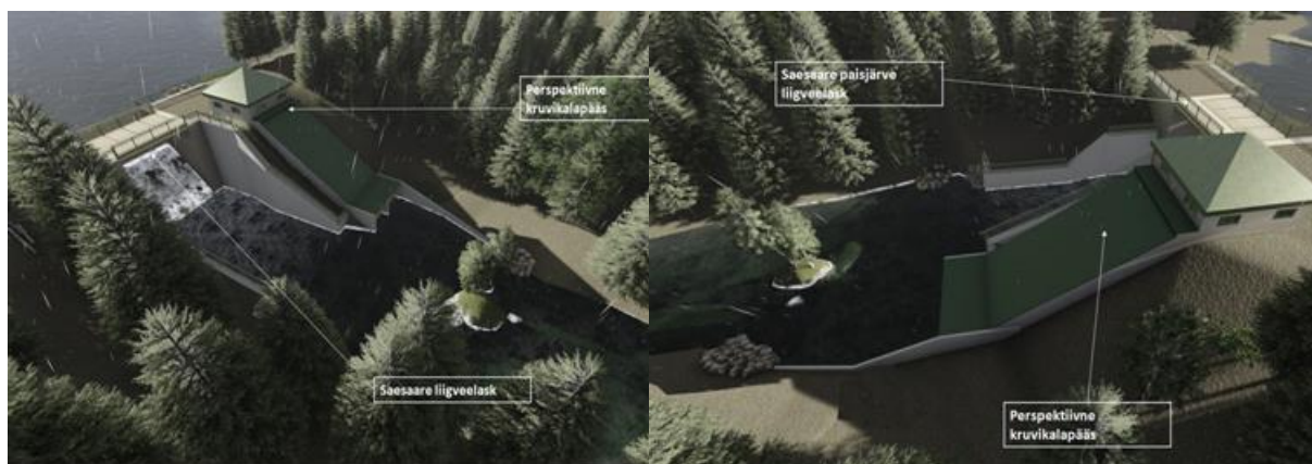
Joonis 4. Joonised: lisanduv HEJ koos kruvikalapääsuga. Allikas: IBUN, 2017
