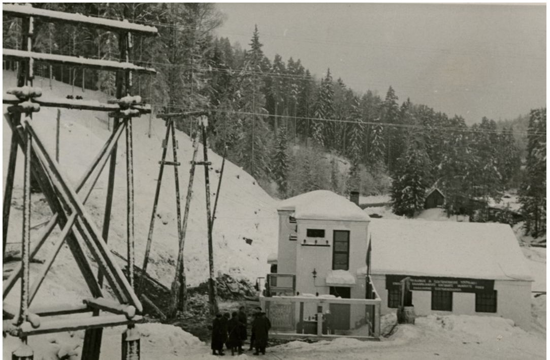
10. Ühendhoone, trafoaedik ja kõrgepingeliini portaalpostid ametliku avamise 23. detsembri 1952 paiku. EPM FP 174:25.
