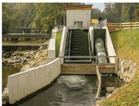
Joonis 3.2. Näidis kruvikalapääsust. Allikas: REHART/Strasser, 2016.
