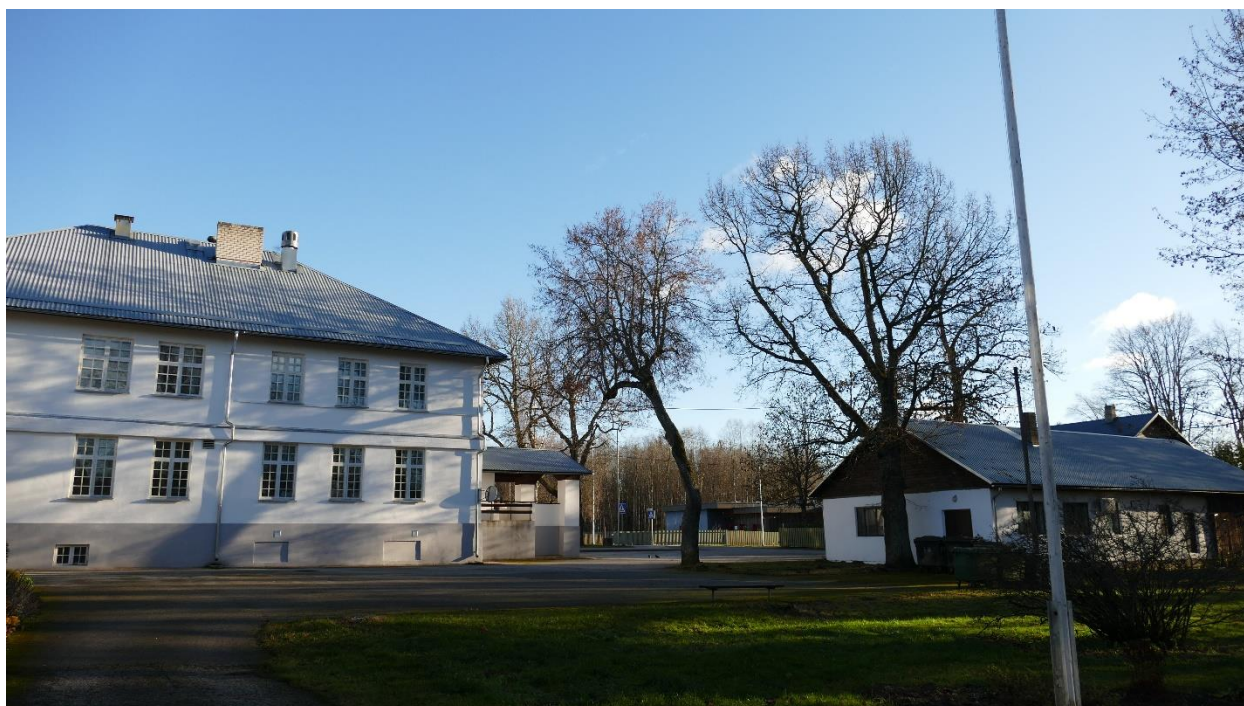
Foto 26. Peahoone tagafassaad novembris 2022. Paremal ümber ehitatud mõisaaegne kõrvalhoone (Sulev Nurme foto).
