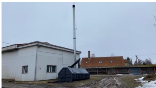
Joonis 3.27. Mooste katlamaja
